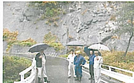
駒ヶ岳線橋梁拡張要望現地調査
