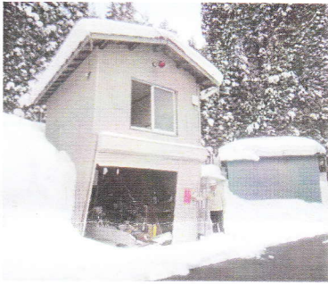
茅村の地震被害視察
