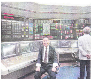
浜岡原子力発電所調査
